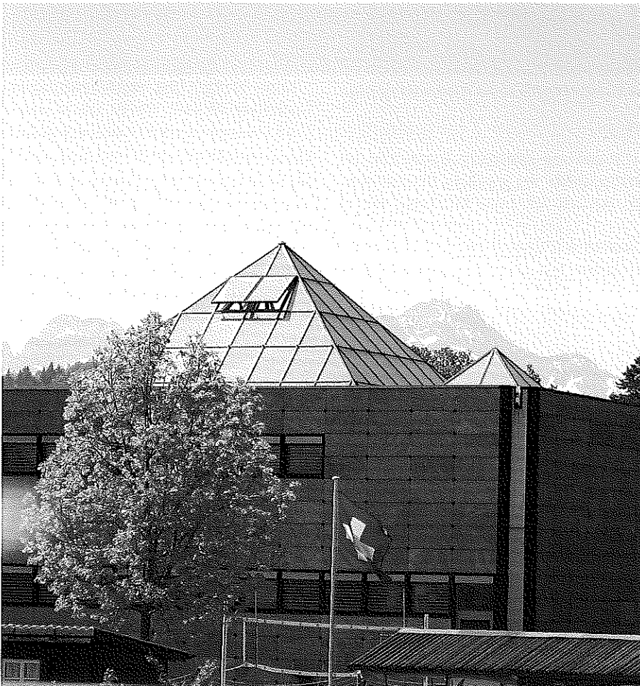
Bibliotheksbäude der Universität St. Gallen mit dem Sântis im Hintergrund.
